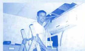
Nicolas Chéri installe le climatiseur du secrétariat de mairie
